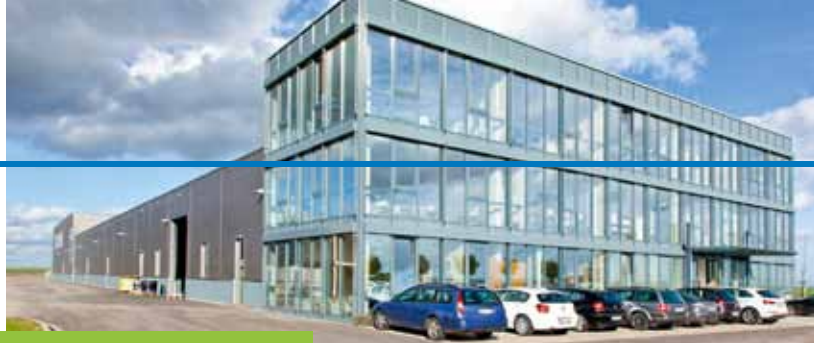
Industrie- und Gewerbegebiet Steitzhof, Verope Service- und Logistikzentrum
