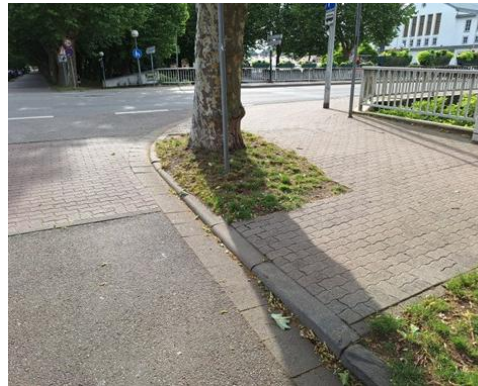
Abbildung 25: nicht ausreichend abgesenkter Bordstein an Querungsstelle
