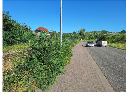
Abbildung 10: Durch Grünwuchs eingeengter Gehweg an der Gottlieb-Daimler-Straße
