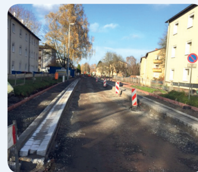
Straßenbaumaßnahmen in der Tilsitstraße
