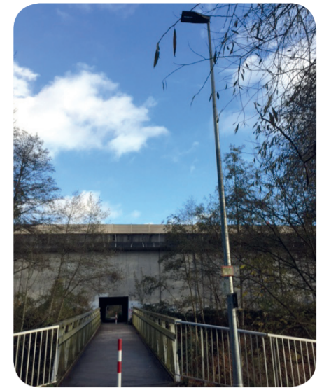
Die höhere Leuchte vor Ein- und Ausgang der Fußgängerunterführung
